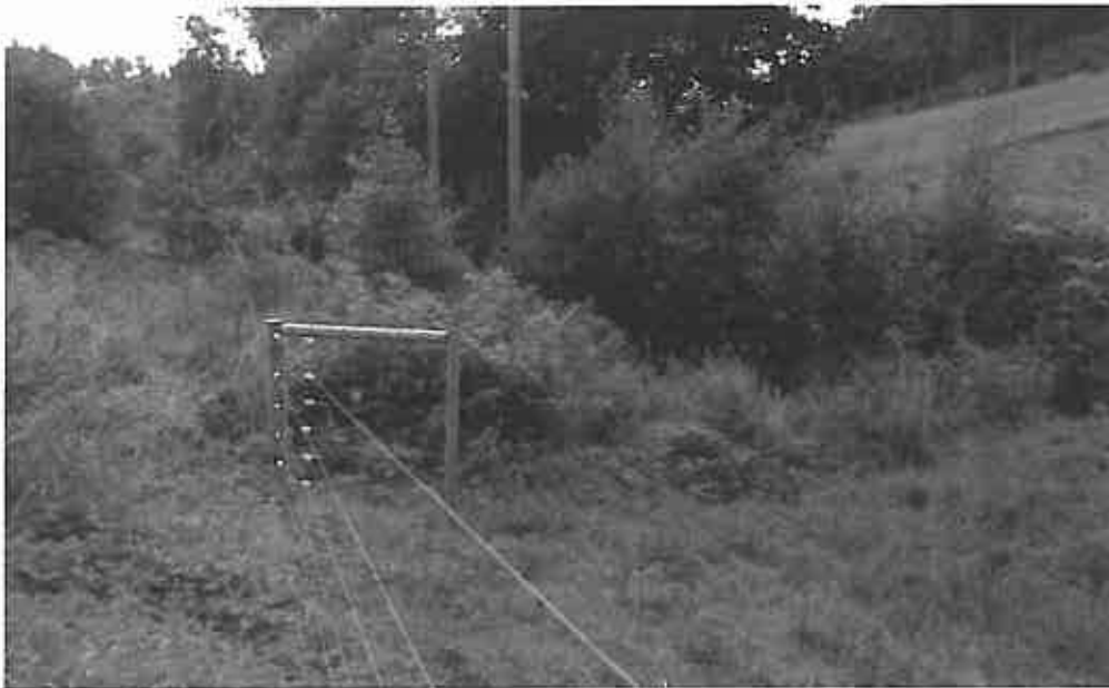
Bilde 2 Viser ferdig oppsatt 6-tråds elektrisk rovviltavvisende strekkjerde. Foto: Leif Larsen
