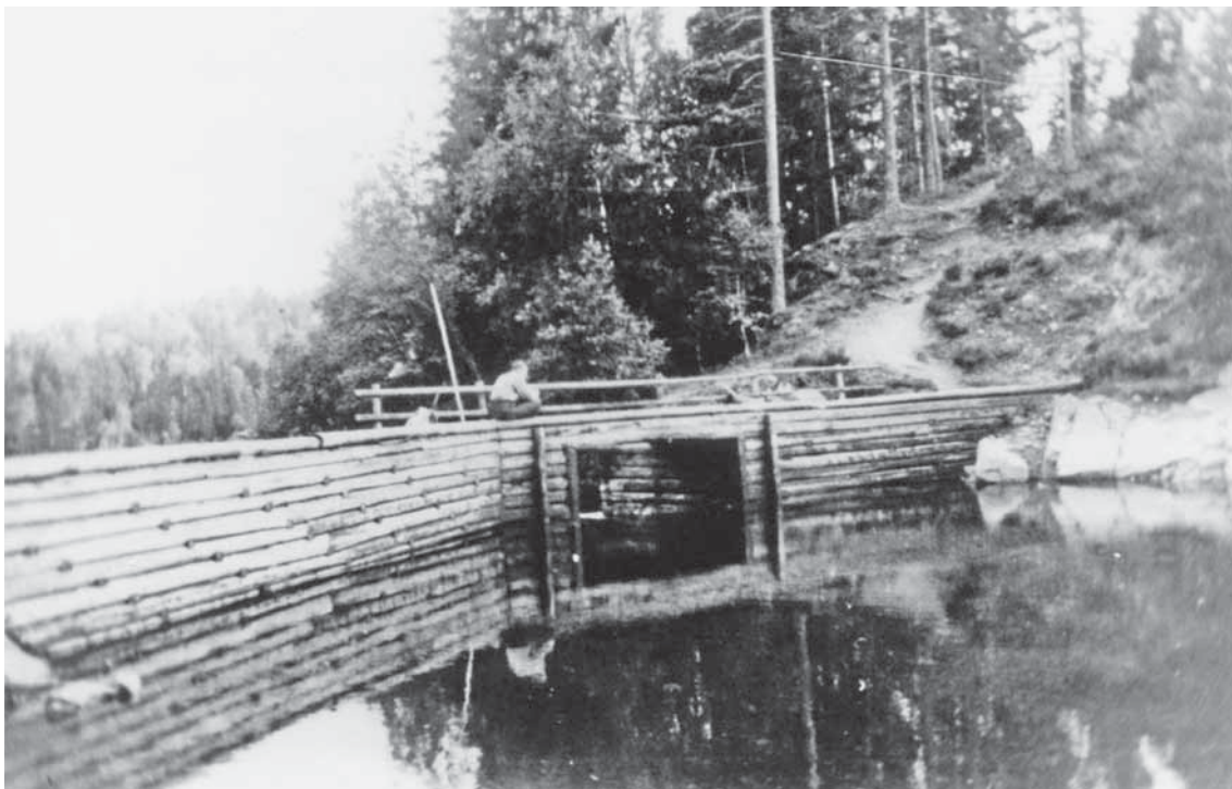
Røvassdammen og flere andre fløtedammer var dobbeltveggede laftedammer fylt med stein. De parallelle veggene var ca. en meter fra hverandre og ble holdt sammen av innlaftede stokker på tvers. Foto: Fløtesjef Svensson, ca 1950.
