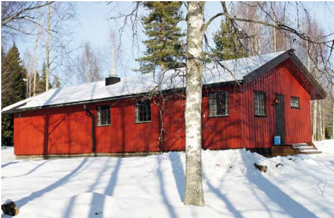
Renseanlegget ved Eidet var det første kloakkrenseanlegget i Rømskog, og kom i drift 1983. De fleste av kommunens innbyggere nord for Rømsjøen er koblet til dette anlegget. Foto: Per Haugen, 2012.
