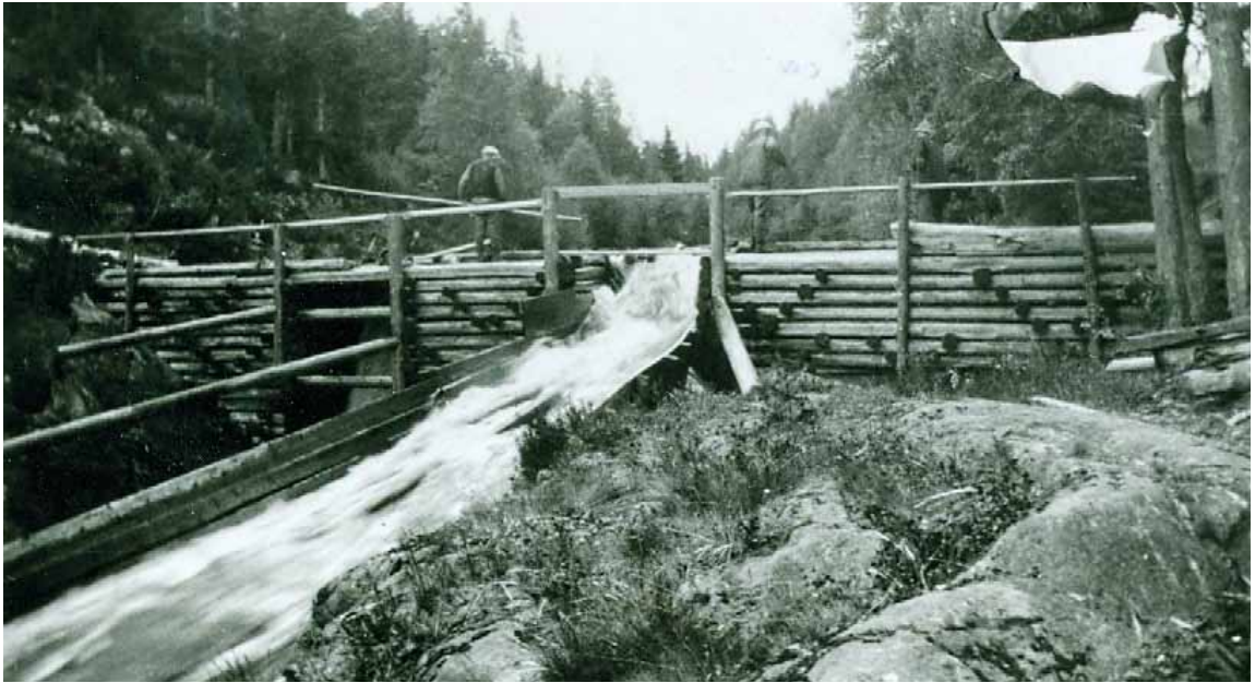
Klommedammen var den nest siste dammen i Langebekk, og lå mellom Systemodammen og Østtukkudammen. Langebekk var her steinete og vanskelig å fløyte tømmer i. Derfor ble det laget en renne slik at det ble lettere å føre tømmer videre nedover i vassdraget. Eier: Jørgen Dahl.
