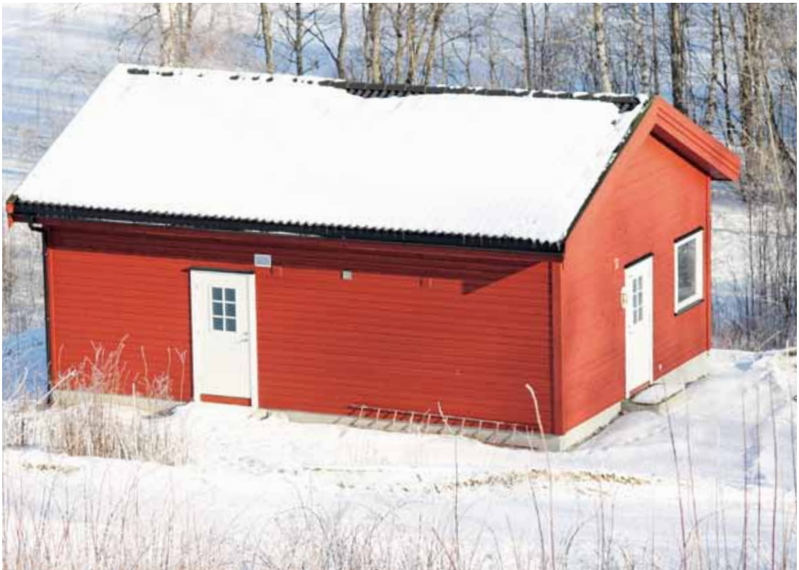
Renseanlegget for Vestsida på Rømskog ble plassert nederst på Haukenesfeltet. Mange hus på Vestsida er nå knyttet til dette kloakkrenseanlegget. Foto: Per Haugen, 2012.
